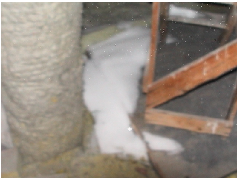
Kuva 3. Lunta yläpohjan tuuletustilassa lämmöneristeen päälle. Kuva on toisesta rakennuksesta.
